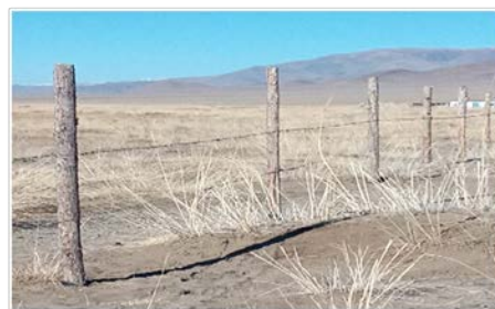
Төмөр тор дутуу татсан 700м хашааны өмөнөх байдал.
