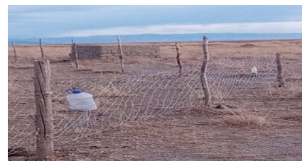
Төслийн хөрөнгөөр сүлжмэл бэлэн тор авч өгч татуулсаны дараах байдал
