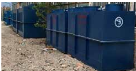
Зураг 28: Монголд хийсэн Аэробны ба анаэробны цэвэрлэх байгууламжууд
