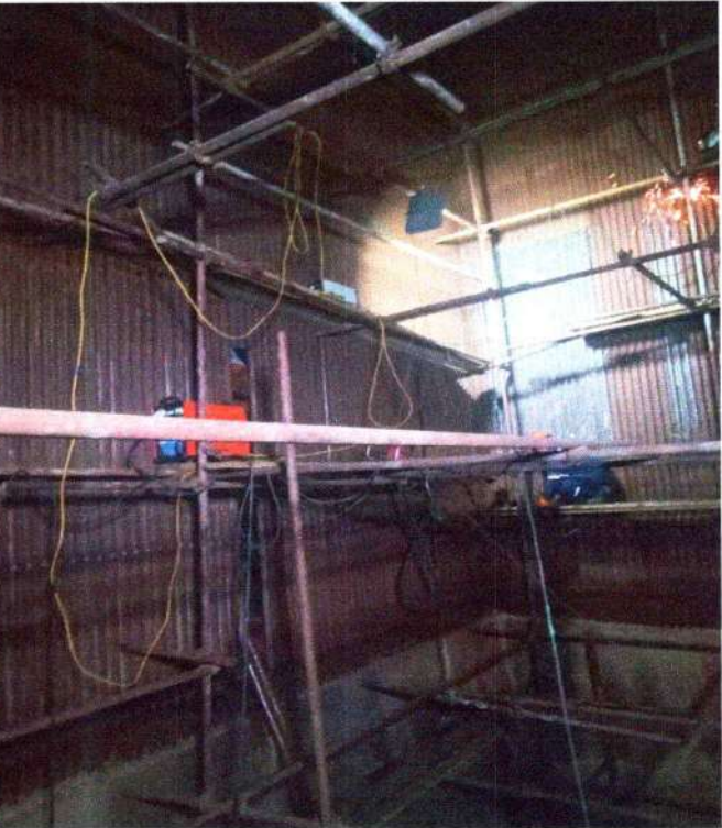
Зуух №2-н галын хотлын экраны засварын ажлын үйл явц.
