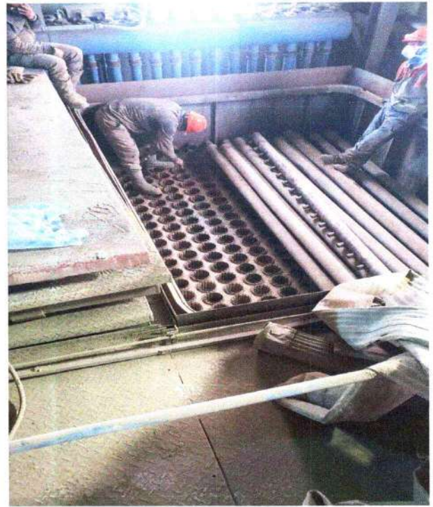
Уутат шүүлтүүрийн №1, 2, 3 уутанд үзлэг хийж цоорсон уут солив.
