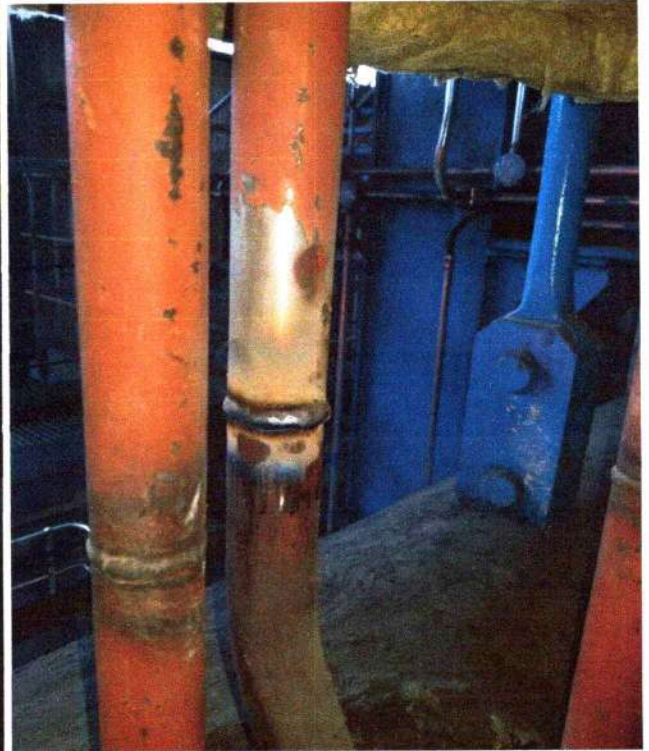
Ус халаагчийн босоо экрануудад гагнуурын оёдолд үзлэг хийж, даралтанд оруулсан үйл явц.
