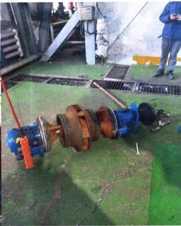
Сүлжээний усны насосны засварын үйл явц
