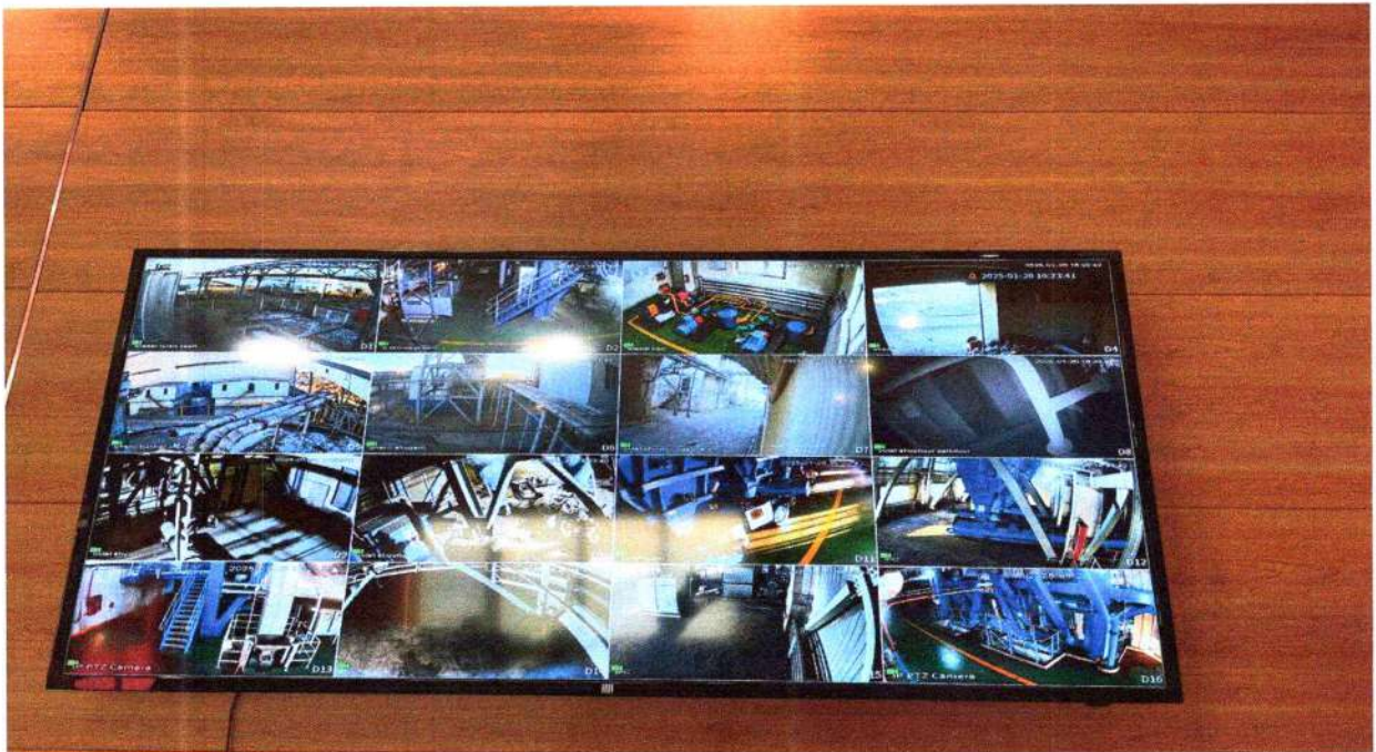
Зуухан цехэд 14 ширхэг камер шинээр суурилуулав.
