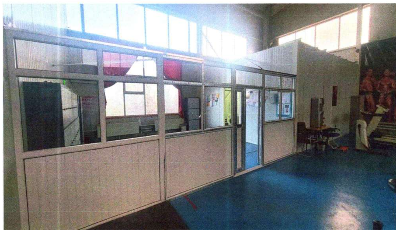
Фитнес зааланд тусгаарлагч вакумм хана хийсэн байдал
