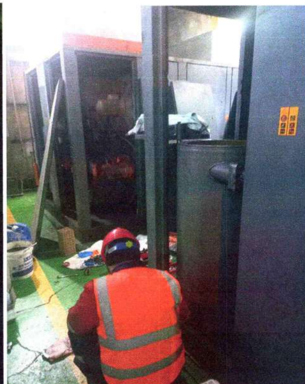
Компрессор №1, 2, 3 8000 цагийн засвар үйлчилгээний үйл явц
