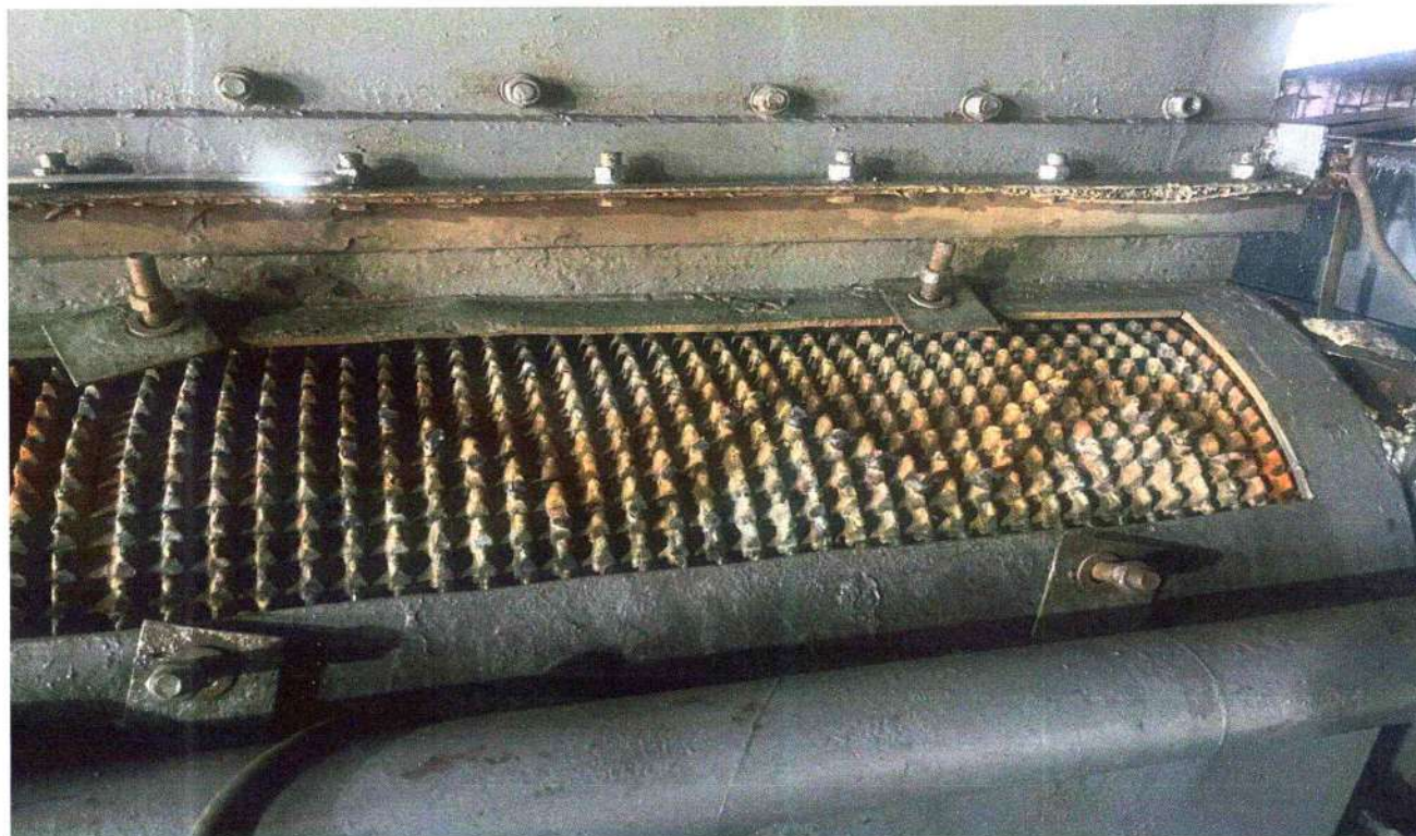
Хоёрдогч бутлуур АБ шүд өндөрлөх болон напловка тавьсан байдал.
