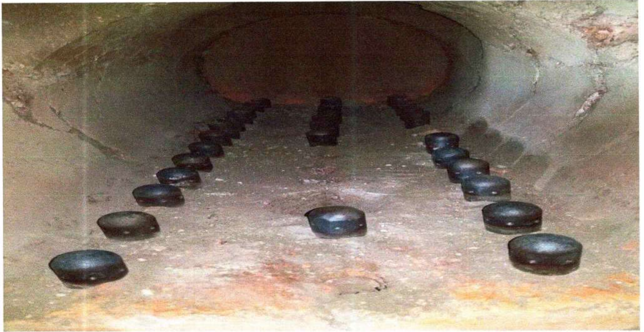
Циклоны хог цэвэрлэж сопло сэтгэсэн үйл явц.
