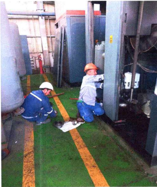
Компрессор №3-т засвар үйлчилгээ хийж буй үйл явц. Насос №1-ийн хаалтны засвар
