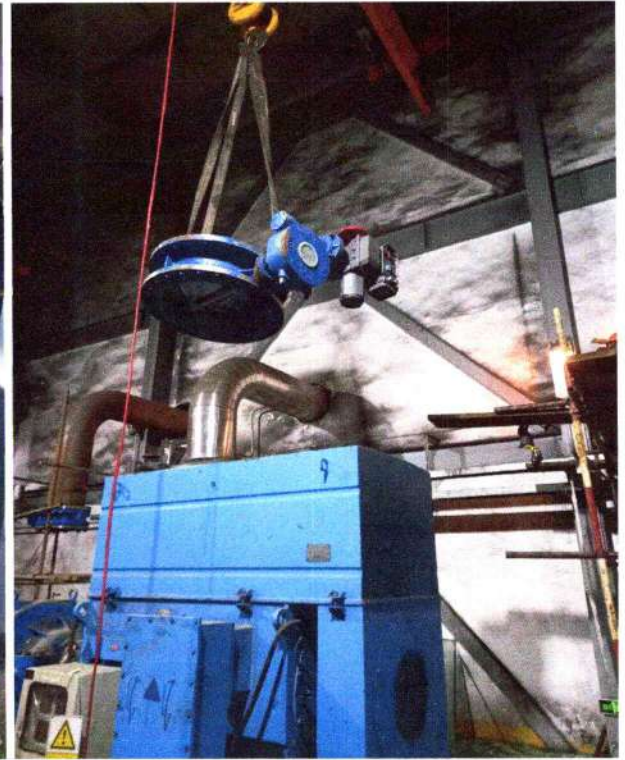
Компрессор №3-т засвар үйлчилгээ хийж буй үйл явц. Насос №1-ийн хаалтны засвар
