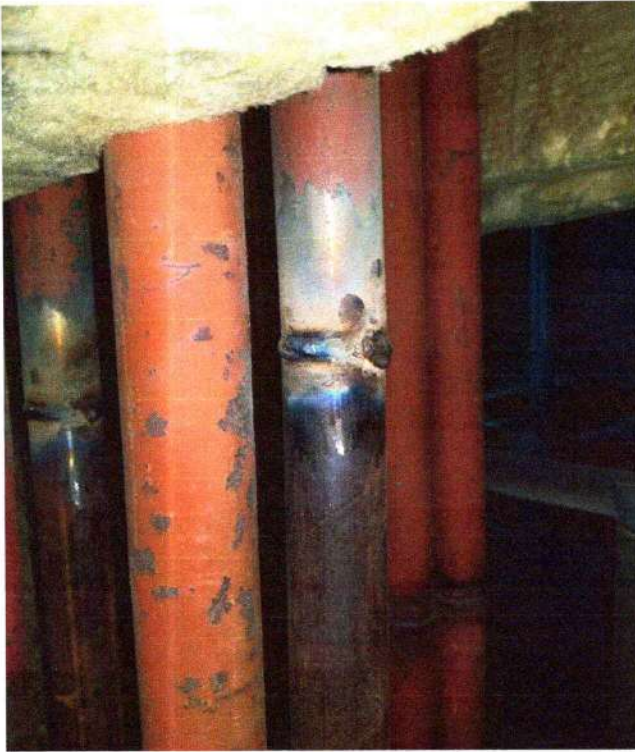
Ус халаагчийн босоо экрануудад гагнуурын оёдолд үзлэг хийж, даралтанд оруулсан үйл явц.
