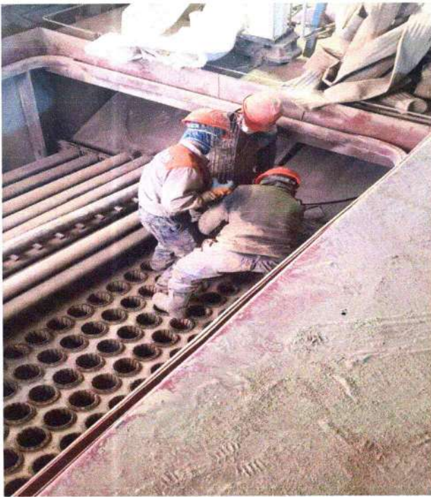
Уутат шүүлтүүрийн №1, 2, 3 уутанд үзлэг хийж цоорсон уут солив.
