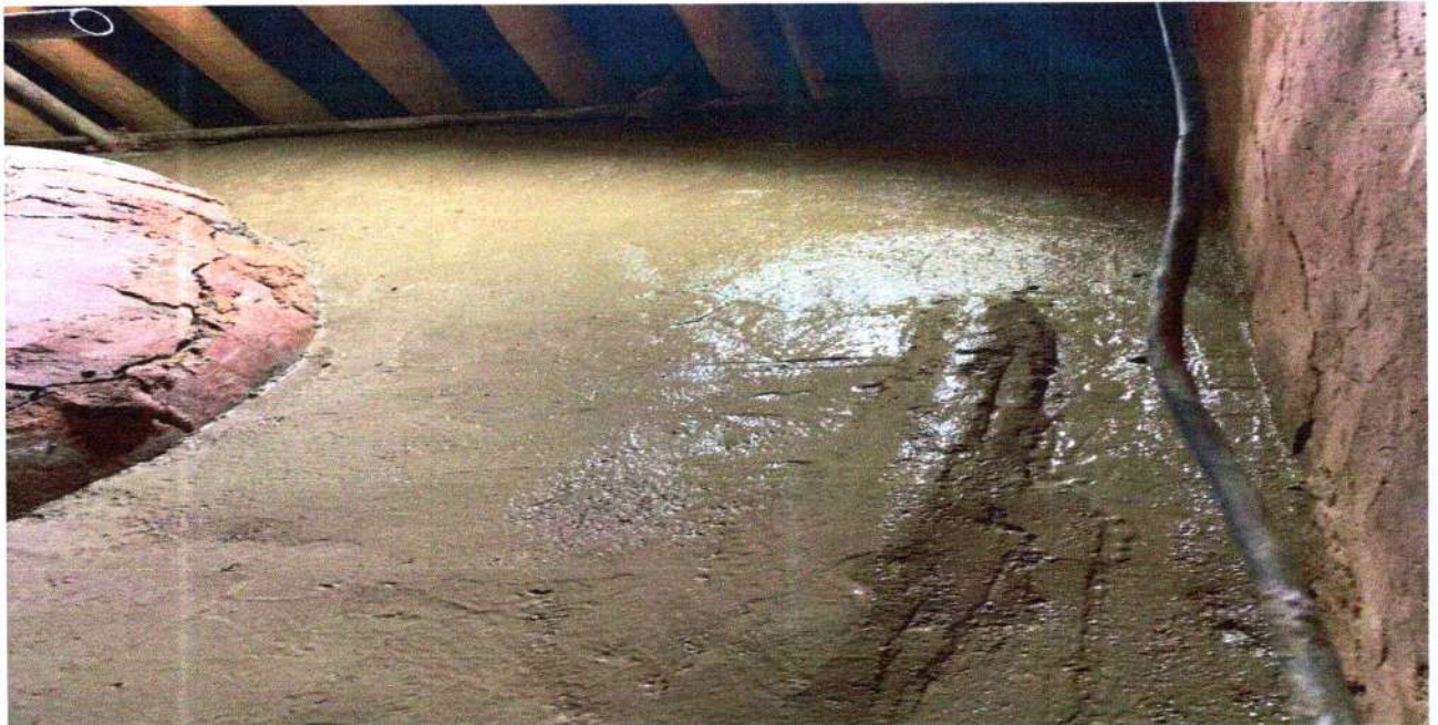
А/Б циклоны 1800-н хоолойг тойруулсан маталттай экранд шавардлага хийсэн ажлын үйл явц
