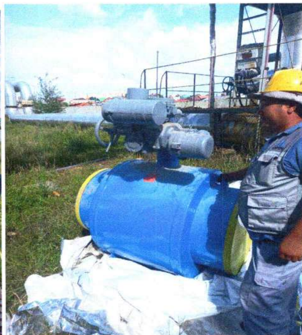
Сүлжээний усны 14-р магистралын өгөх шугамд шинээр Ду700мм-ийн хаалт шинээр суурилуулж буй үйл явц
