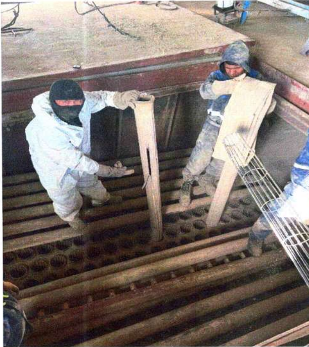
Уутат шүүлтүүрийн №1, 2, 3 уутанд үзлэг хийж цоорсон уут солив.
