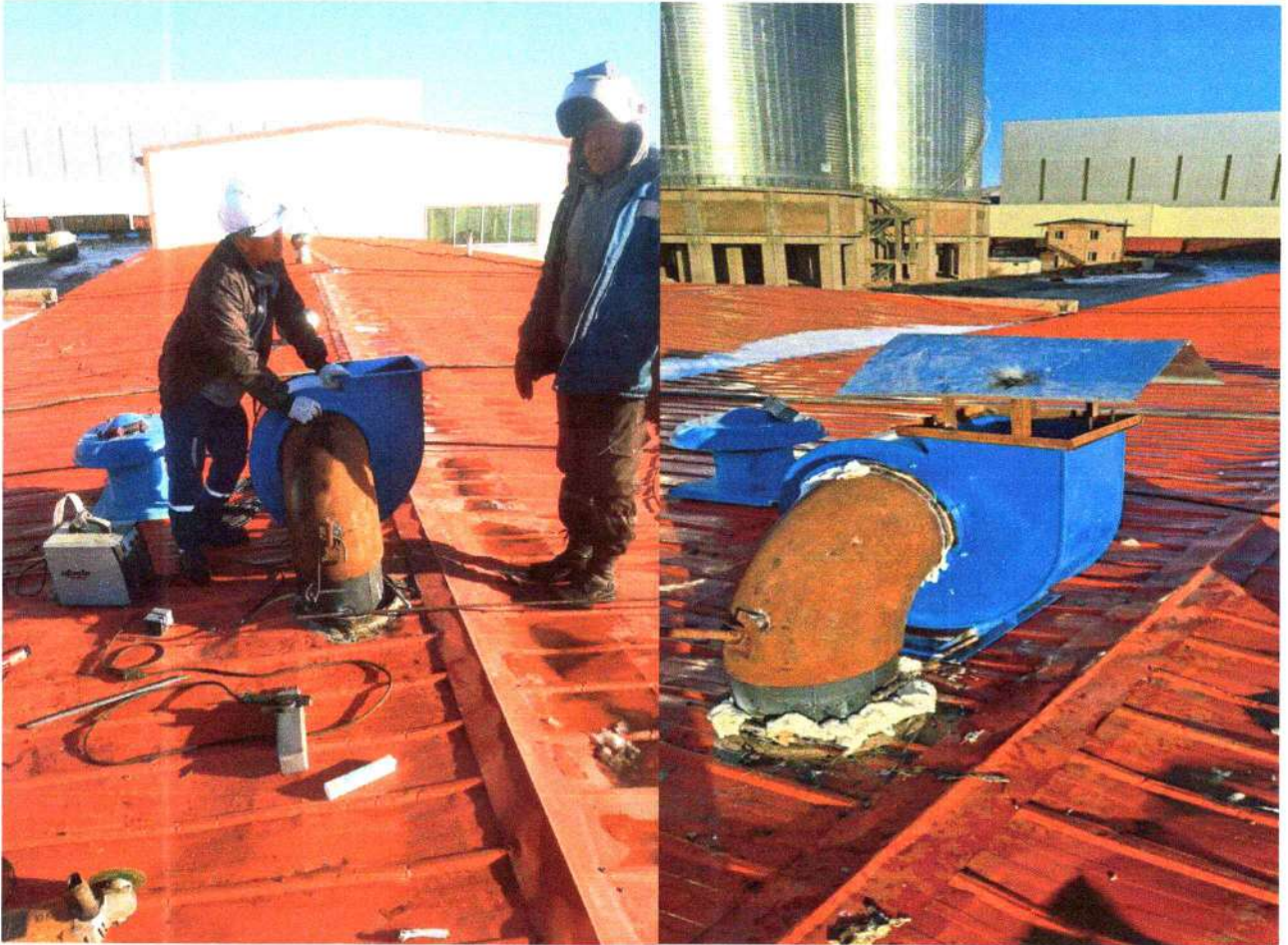
Цайны газрын дээвэр дээр агааржуулалтын хөдөлгүүр суурьлуулсан байдал.
