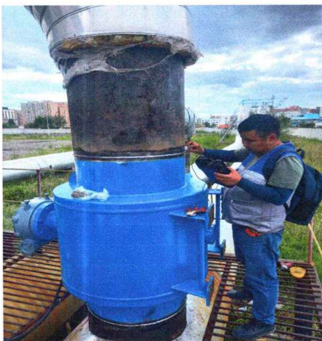
Сүлжээний усны 14-р магистралын өгөх шугамд шинээр Ду700мм-ийн хаалт шинээр суурилуулж буй үйл явц
