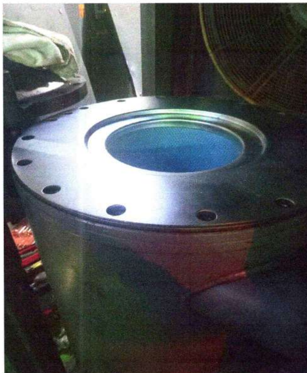
Компрессор №1, 2, 3 8000 цагийн засвар үйлчилгээний үйл явц
