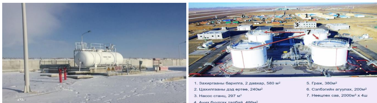
Зураг 16. Шатахууны агуулахын байгууламж. Агуулахын хэрэглээний дизель түлш хадгалах 20м 3 -ийн хэвтээ цилиндр ган сав
