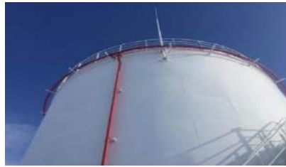
Зураг 16. Галын усан сан, Сав хөргөх, усан хөшиг үүсгэх тоног төхөөрөмжийг байрлуулсан байдал
