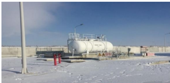
Зураг 12. Шатахууны агуулахын байгууламж. Агуулахын хэрэглээний дизель түлш хадгалах 20м 3 -ийн хэвтээ цилиндр ган сав
