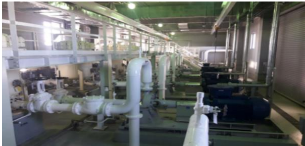
Зураг 15. Шатахууны агуулахын насосны станц
