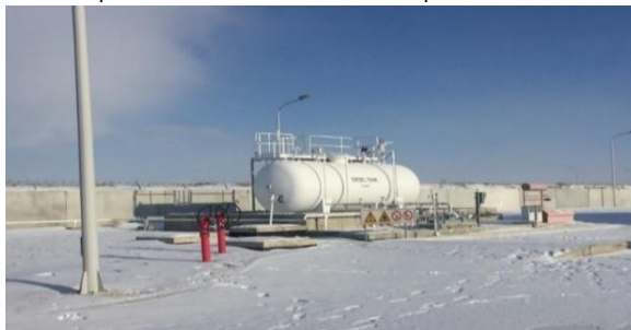
Зураг 1-12. Шатахууны агуулахын байгууламж, агуулахын хэрэглээний дизель түлш хадгалах 20 м 3 -ийн хэвтээ цилиндр ган сав
