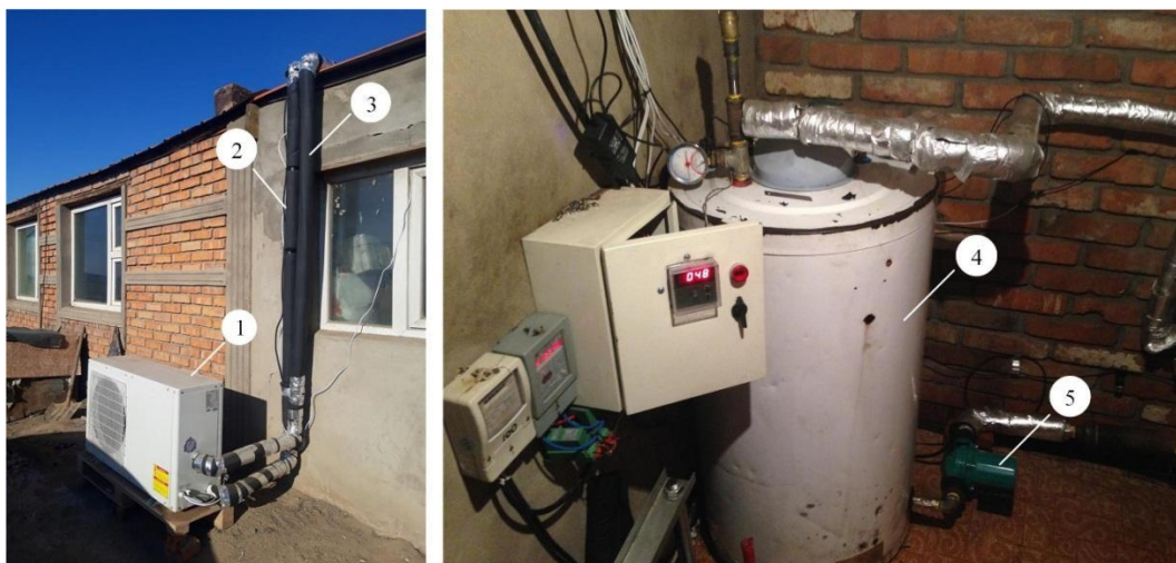
Зураг 2. FA-015 Агаар – усны дулааны насосыг халаалтын системд суурилагдсан байдал. 1 – агаарын эх үүсвэрийн дулааны насос, 2 – дулааны насосын оролтын хоолой, 3 – дулааны насосын гаралтын хоолой, 4 – дулаан нөөцлөх сав, 5 - насос
