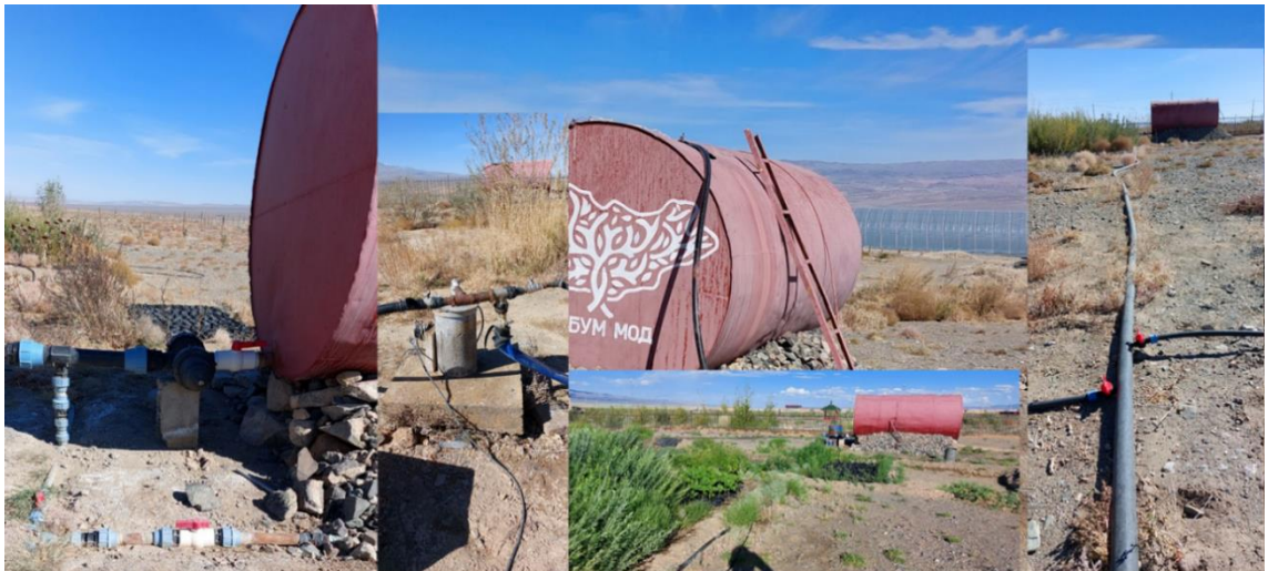
Зураг 2. 10тн-ын багтаамжтай ус хуримтлуулах сав болон дуслын усалгааны системийг суурилуулсан зураг
