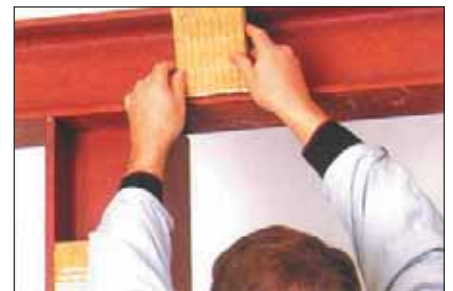
Цавууг түрхэхээс өмнө бэхлэгч шаантагнууд маш сайн суурилагдсан байх шаардлагатай.
