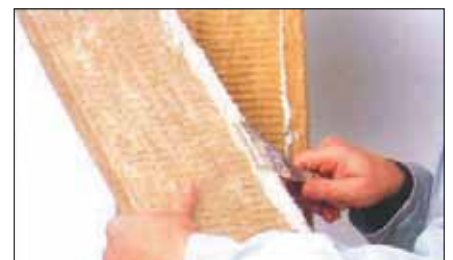
Цавууг түрхэхээс өмнө бэхлэгч шаантагнууд маш сайн суурилагдсан байх шаардлагатай.
